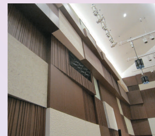
「ブラームスホール」の壁面。反射音を効果的に客席へ届けるため、凹凸を設けた壁面は垂直ではなく、高い天井に向かって広がった構造となっている(写真提供: 永田音響設計)
