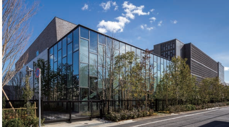
▲ブラームスホール外壁： ベートーヴェンホール(右)の格子状のデザインパターンを踏襲している
