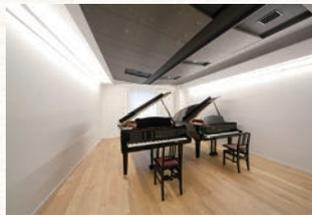
◀レッスン室(ピアノ)／フラッターエコー防止のために、壁や天井の平行面を排している。また、使用楽器や各部屋の広さを考慮して、天井吸音板の可変的なレイアウトにより、残響時間を調整している
