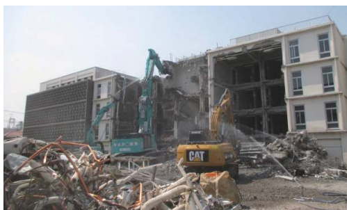
▲ 3号館建屋解体状況 (5月27日)
