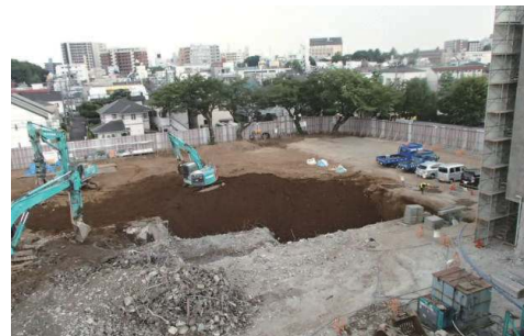
▲ 1, 2, 3号館建屋基礎解体状況 (7月29日)
