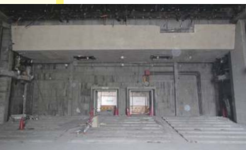
▲ 7号館(旧モーツァルトホール)内装解体状況 (5月28日)
