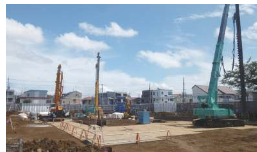
▲ 南側 山留杭打設状況 (9月2日)
