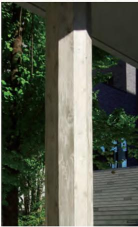
トを打設する「本実型枠コンクリート工法」により天然の杉板の木目が転写されており、無機質になりがちなコンクリートが表情を見せています。
