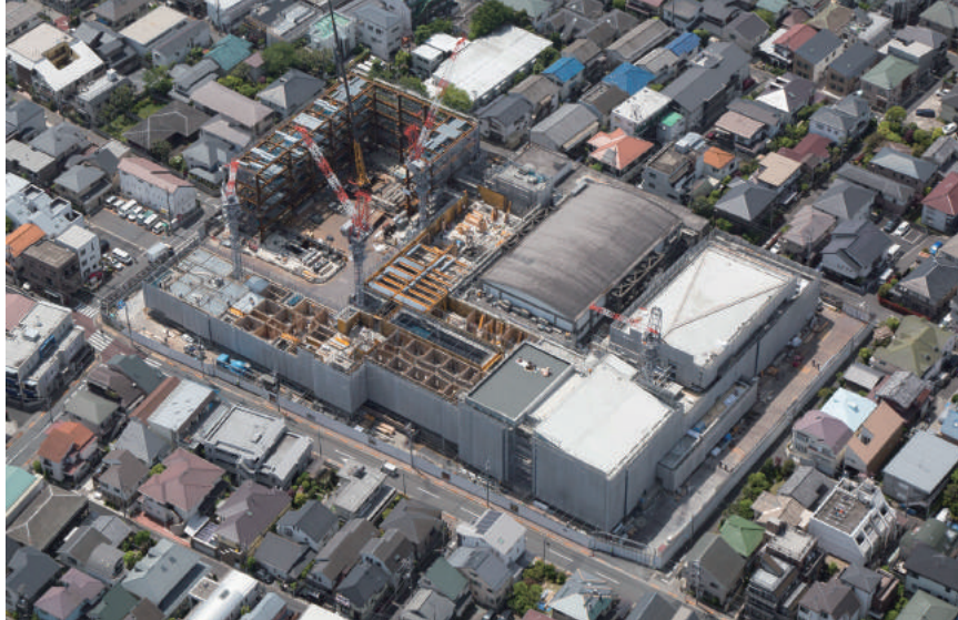
▲ 現場全景 空撮 (平成28年4月25日)
