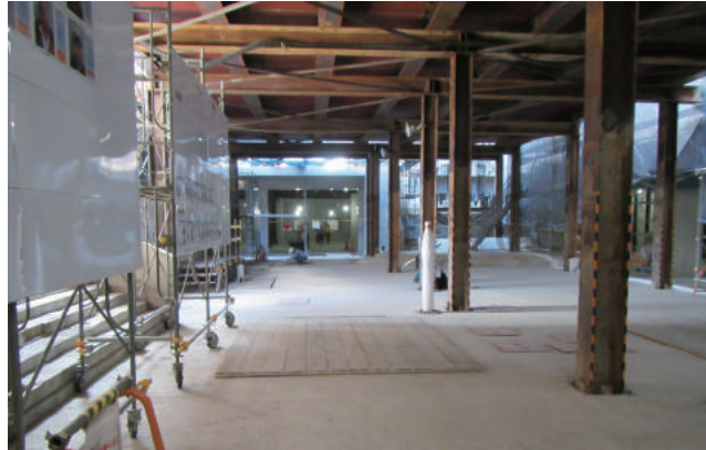
▲ サンクンガーデンに設置した仮設の作業台 (平成28年6月2日)
