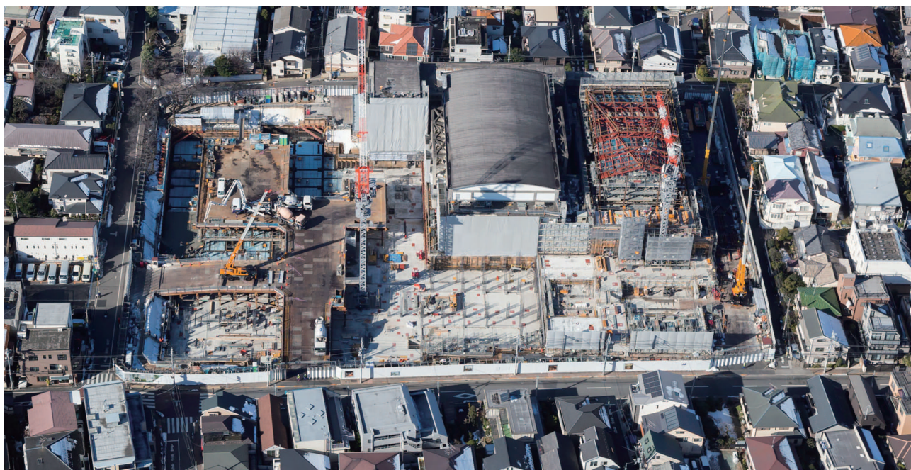
▲ 現場全景 空撮 (平成28年1月22日)
