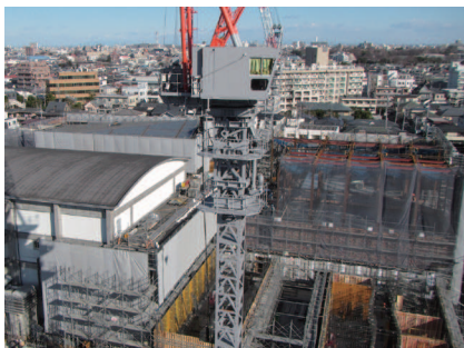
▲ ブラムスホール棟(左奥)、リハーサルホール棟(右奥) (平成28年3月1日)
