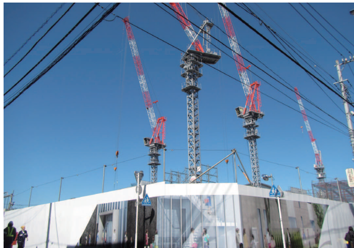
▲ 現場南東から見たタワークレーン (平成28年3月1日)
