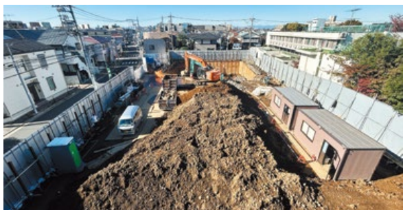
東からの「むらさき寮」解体工事風景（2024年11月28日撮影）
